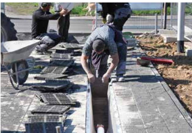
El sustrato se rectifica en la altura prescrita.
