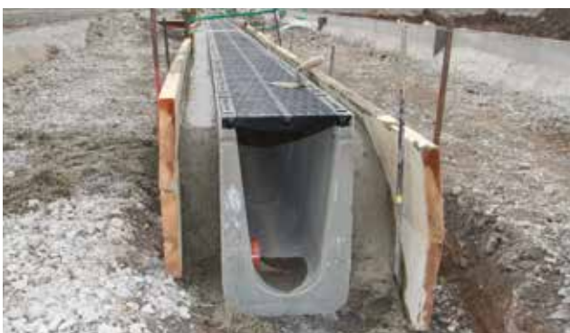
Se colocan canales DRAINFIX CLEAN.
