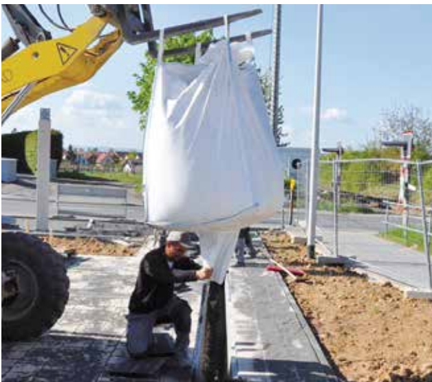
Se rellena el sustrato de filtro.
