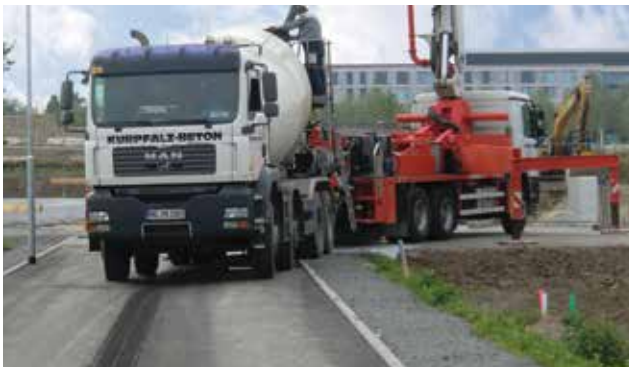
Los canales soportan cargas altas y pueden transitar sobre ellos vehículos pesados durante la fase de construcción.
