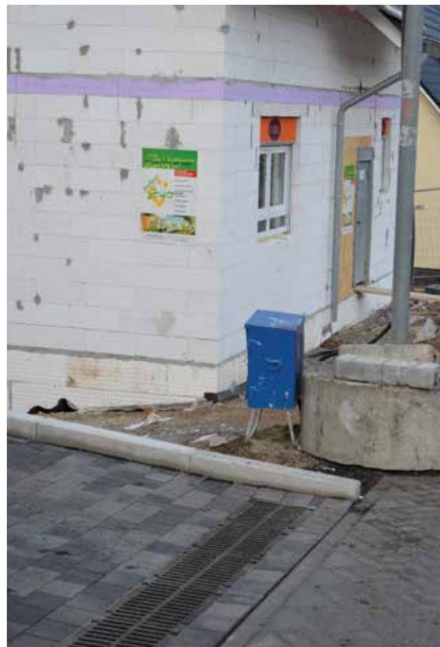
Desde los canales, el agua se lleva a un sistema de infiltración por zanjas en el que se infiltra poco a poco.
