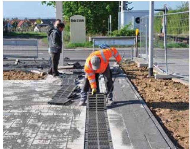
Las cubiertas se bloquean con el cierre rápido SIDE-LOCK.
