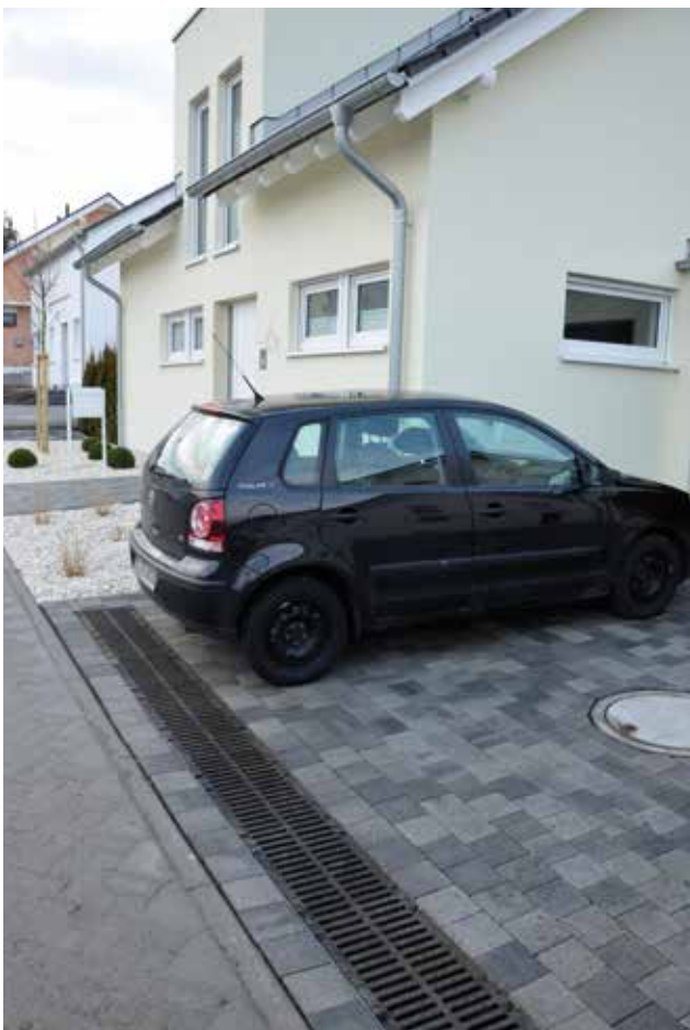
DRAINFIX CLEAN retira las aguas pluviales acumuladas en azoteas y aparcamientos.
