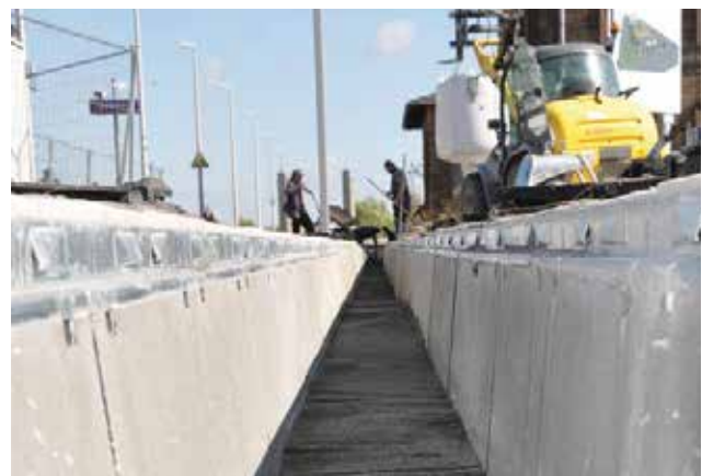
La altura de canal que queda libre sirve como volumen de retención para el caso de grandes precipitaciones.
