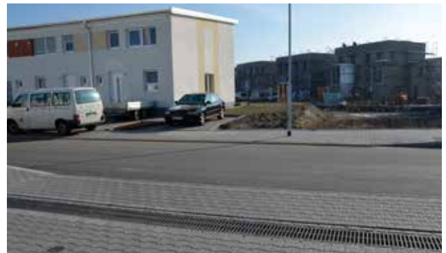
Los canales se pueden integrar en todas las superficies que se desee.
