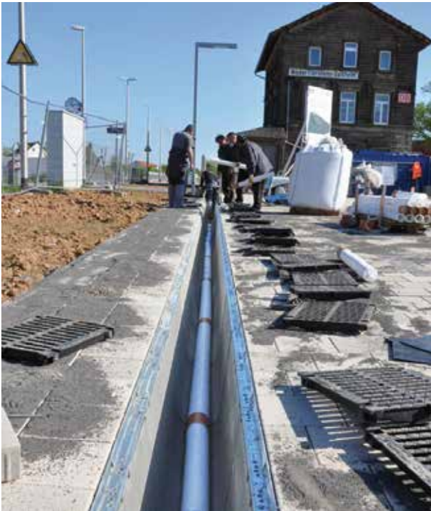
Colocación de los tubos de drenaje en la cadena de canales de DRAINFIX CLEAN.
