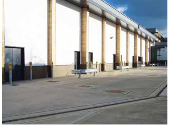
Instalación en superficie de hormigón
