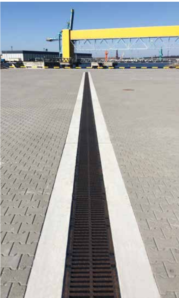
Terminal de contenedores y puerto, Letonia
