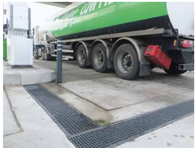
Estación de servicio, Inglaterra
